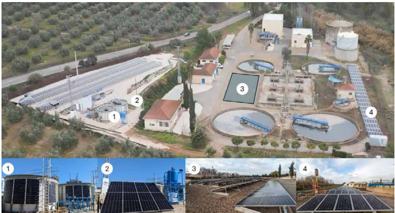
Vista aérea de la EDAR de Linares (Jaén) y distribución de los paneles innovadores incorporados:
