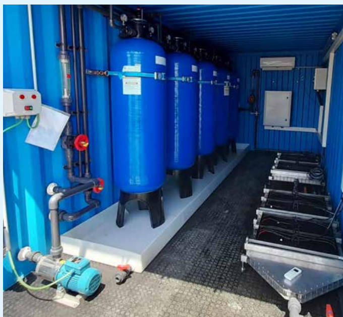
De izquierda a derecha, skid de filtros de lavado en continuo y semicontinuo; contenedor de desinfección con UV, O 3 y H 2 O 2 .
