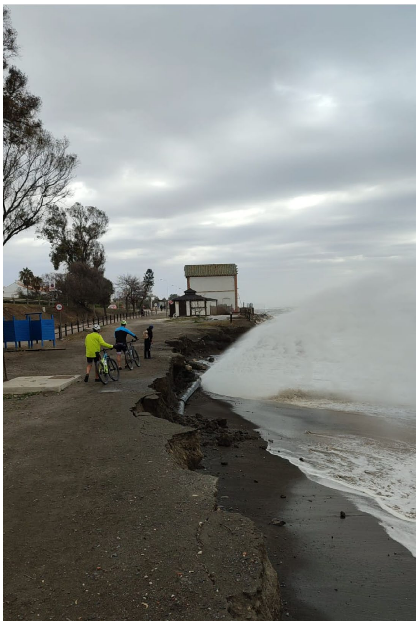
● Avaria em Vélez-Málaga, Espanha.
