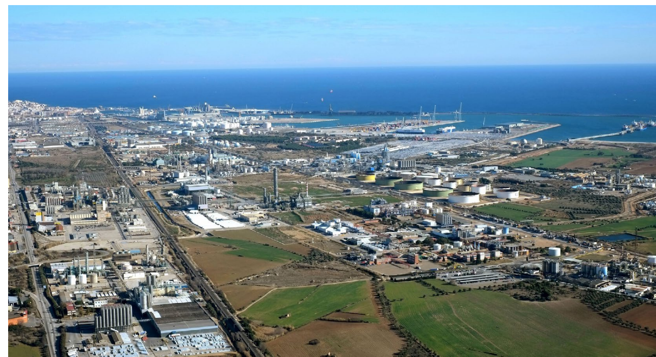
● Vista aérea de AITASA, Tarragona, Espanha.
