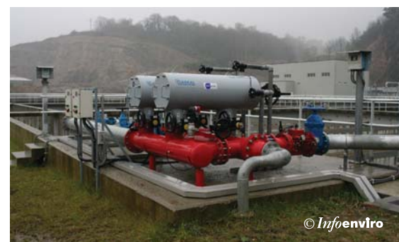
Filtros de malla Hidroglobal a 200 micras para línea de refrigeración del secado de fangos
